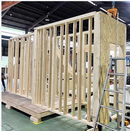
工場にて階段室の骨組みとパネルを組み立てる
