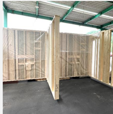
クレーンで運搬・設置
